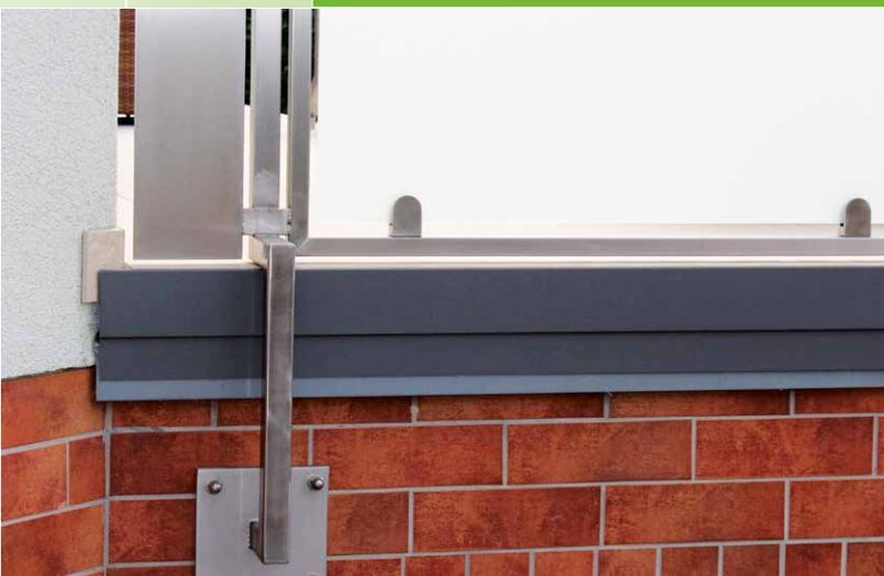
Flexible und einfache Montage am Ende der Verlegung.
